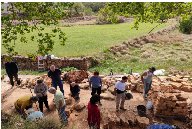
Taller de pedra en sec a Cortes de Arenoso
